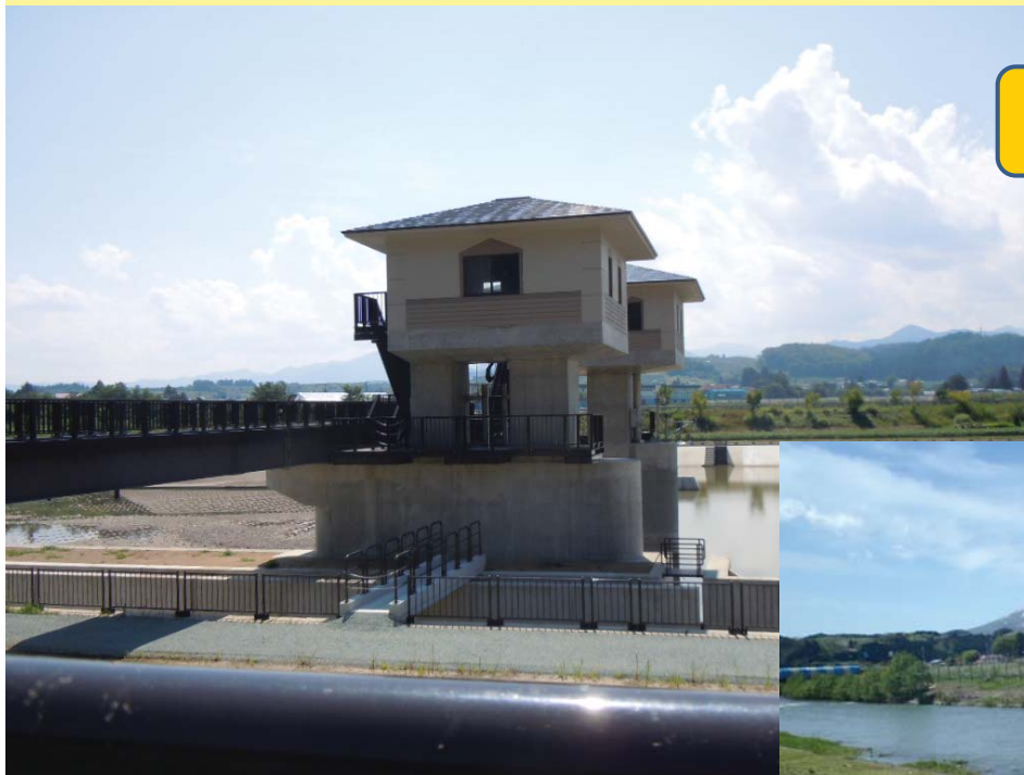
岩木川統合 頭首工
