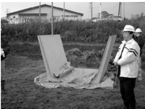
るとのことでした。新しく設置するトラフは通常のものとは違い接合断面にはゴムが装着されており、設置した後焼きごてで溶着するものでした。また溶着作業は製造業者で行っているとのことでした。
