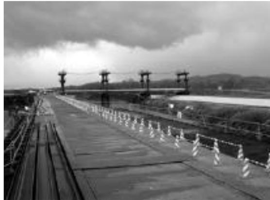
ジャッキを採用して通常必要となる仮設橋の撤去・再設置にかかる期間(約2ヶ月)を短縮しているとの説明を受けました。ジャッキアップ橋は、各橋に4つ設置されているジャッキによって規定の高さまで3時間で昇降させるもので、この橋設置のため、第一期工事の総工事費72億の内、40億が仮設工事費として計上されており、通常の工事より仮設工事費の金額が大きくなっているとのことでした。
