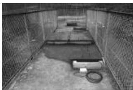
調圧水槽での水位計測
