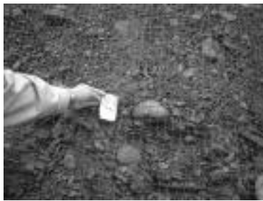
▲掘削法面の玉石状況
