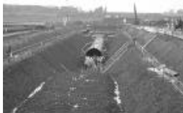
▲FRPMφ3,000敷設状況
