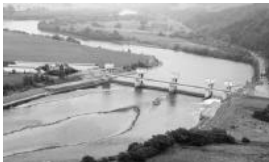
▲北空知頭首工
