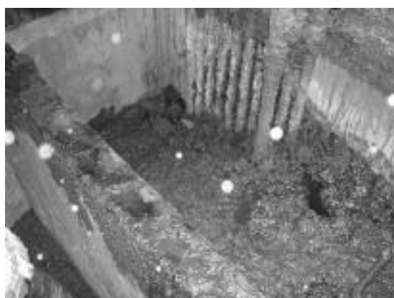
図7 殺菌槽でのスラッジの堆積
