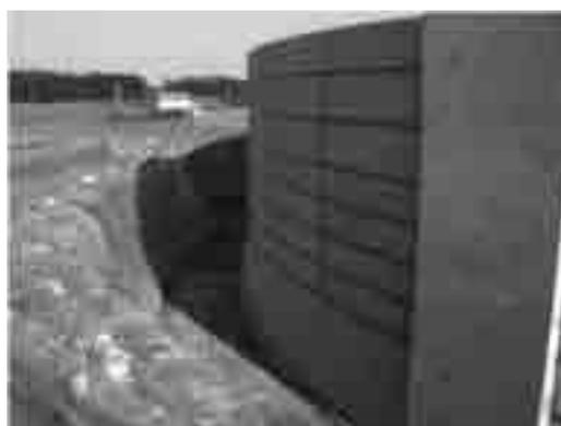
写真-4：半地下式の配水調整槽
