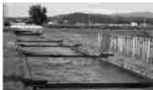
側壁傾倒により改修が必要な幹線用水路
