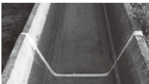
写真-10 目地補修工の仕上がり具合
