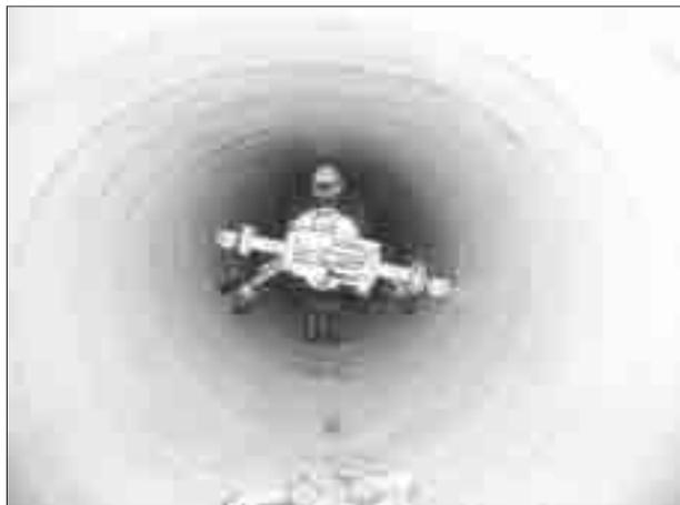
⑦既設管とストリップ更生管の隙間に充填剤を注入し
