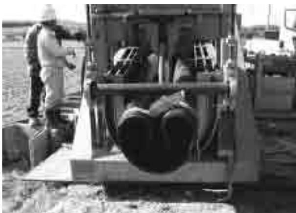
写真-4 ハート形に成型したPE管
