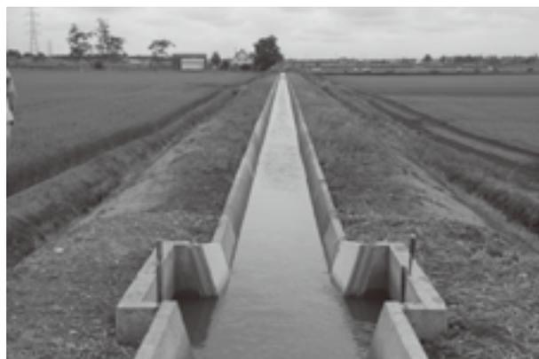
写真-11 補修した用水路の通水状況 (2012年6月撮影)
