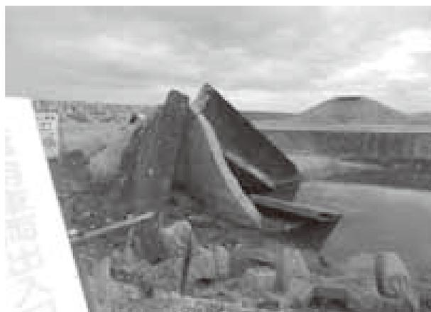
下の写真は復旧工事中の堤防で奥の盛り土は津波抑止林の造成工事で林野庁所管です。この造成工事は、液状化の被害を防止するために植樹帯に盛り土を行いそこに、苗木を植え付けるというもので、一定の幅を確保するために、相当量の盛り土を行っているとのこと。
