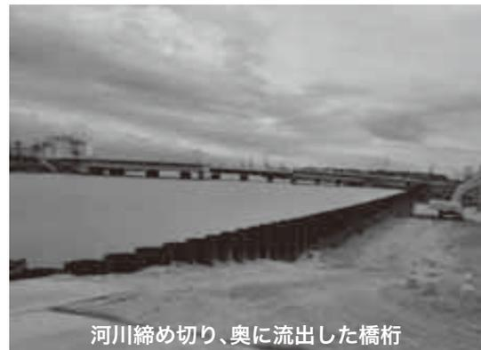
河川締め切り、奥に流出した橋桁
