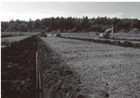
写真-6 暗渠排水工事(農地保全工)
