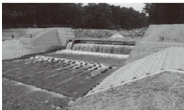
写真-6 チロル型式からバックストリーム型式に変更された石山頭首工（外観）
