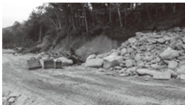
写真-8 施工中に発生する玉石
