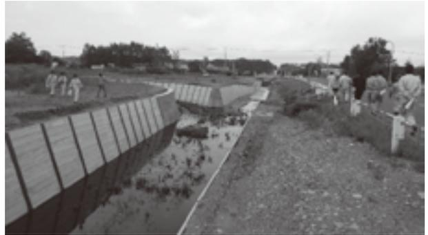
写真-2 柵渠断面の合流工
