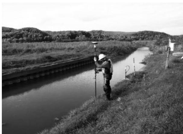
写真-3 測量調査(メッシュ測量:GNSS)
