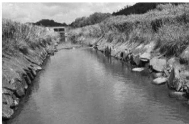
写真-6 川西幹線用水路(地震による張りブロック護岸の変状・崩落)(研修会資料より)
