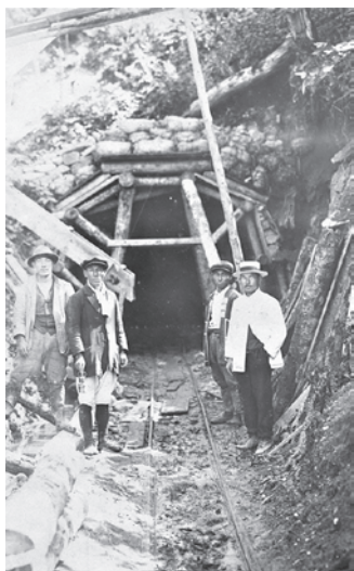
写真-3 ずい道(トンネル)工事 大正14年 人の手に頼らざるを得ない時代、 工事は困難を極めた。
