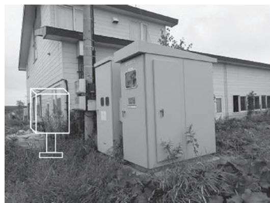
写真-16 切替盤設置イメージ
