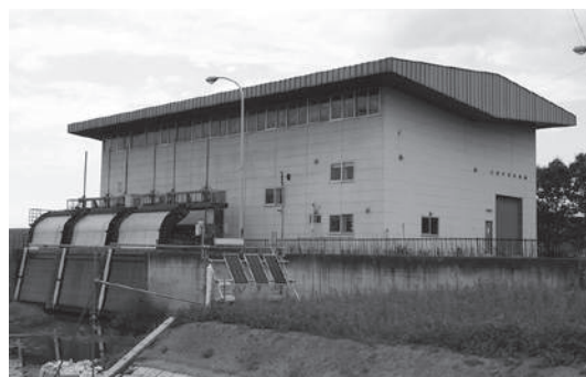
写真-5 上統内排水機場
