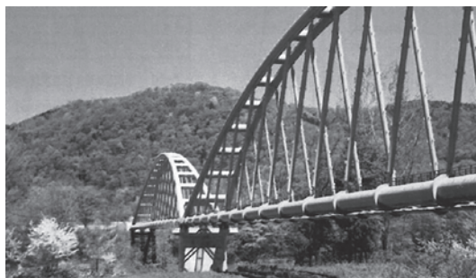
写真-10 神竜水管橋
