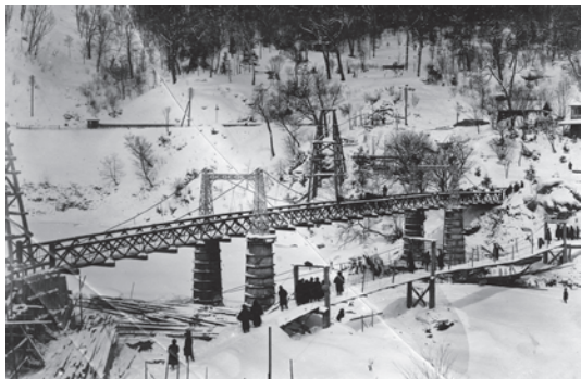
写真-1 神龍橋 右に見える橋は通称「針金橋」
