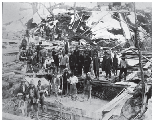
写真-4 湾管工事 大正14年頃 当時はすべて手作業で、石狩川を横断する湾管(逆サイホン管)も現場で生コンクリートを練り込み造られた。
