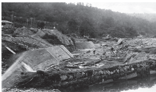
写真-2 神龍導水門の基礎工事状況 大正13年10月頃
