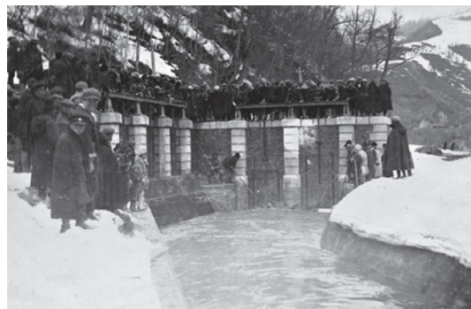
写真-5 取水口整水門前 昭和2年4月10日 待望の石狩川取水が可能となる。
