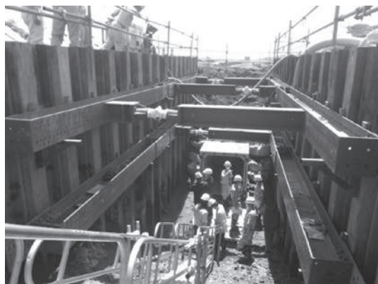
写真-2 導水路工事 開削状況
