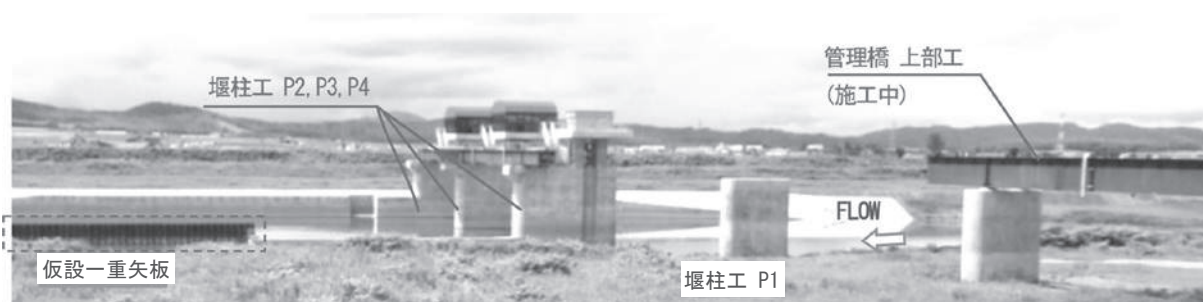
写真-1 改築頭首工 現地状況（左岸堤防から撮影）
