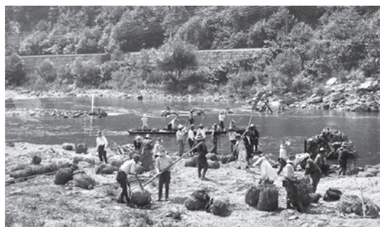
写真-6 導水門前の渇水対策 仮締切状況 昭和5年7月頃 渇水期になると組合員総出で蛇籠積みを行い、取水出来るまで水位を上げる必要があった。
