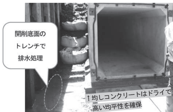
写真-3 ボックスカルバート据付状況
