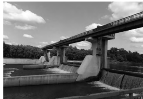
写真-5 大雪頭首工全景(下流側)
