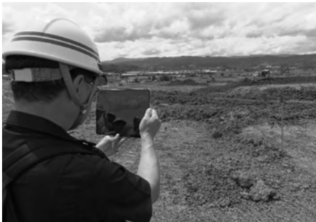
写真-4 AR(拡張現実)技術を活用した丁張検査
