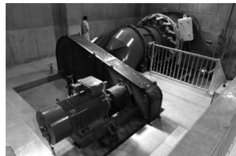
写真-8 S形チューブラ水車(建屋内の水車)
