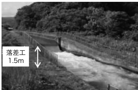
写真-6 施工前(統廃合前)の落差工(研修会資料より)
