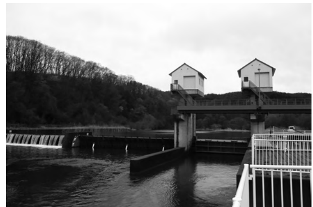
写真-2 美里頭首工
