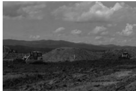
写真-2 ICT建設機械による基盤造成工の施工状況
