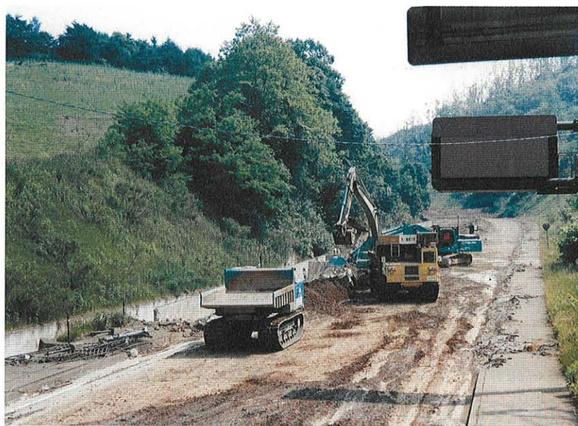
板谷川工区 遊砂池掘削状況
