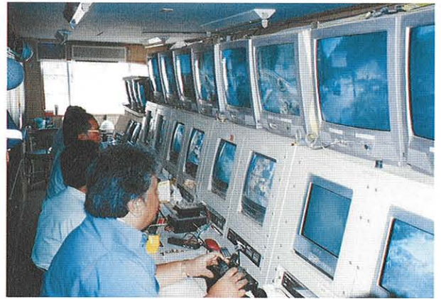
写真2 移動操作室内作業状況
