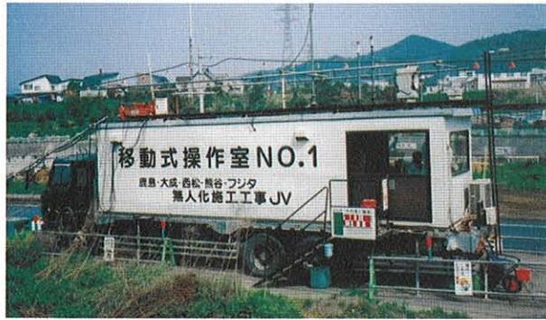
写真1 移動操作室全景 国道230号上に設置
