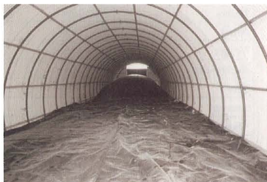
図－8 簡易型ガス貯留設備の例
