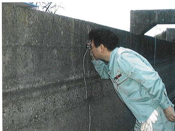
図-3 ひび割れ調査状況
