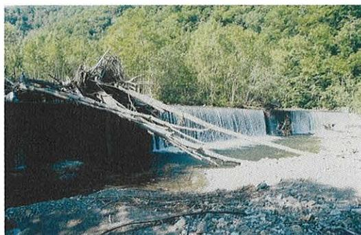
写真7 砂防ダム溢流状況
