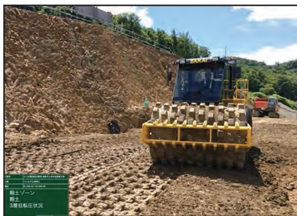
写真－1 上下流方向転圧
