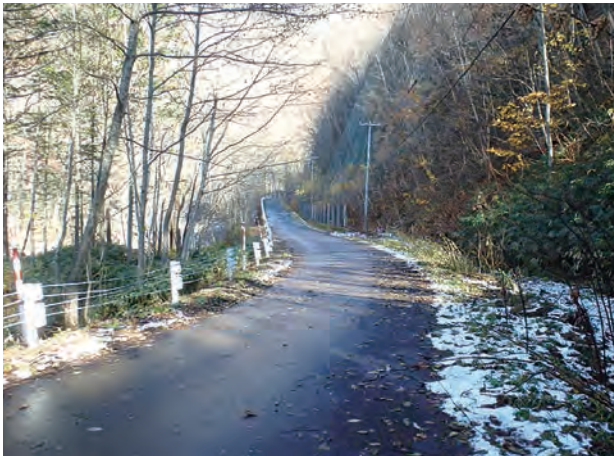
写真－1 狭隘な区間
