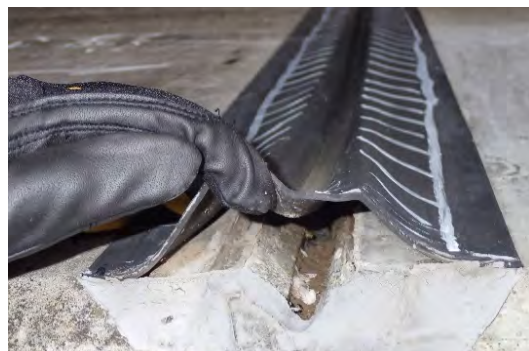
図－11 DFTジョイント工法の状況（平成27年）
