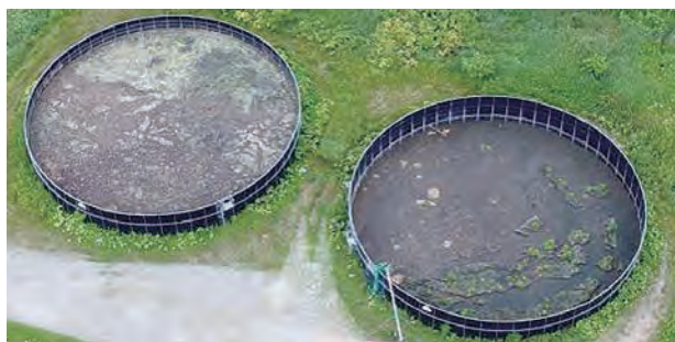
写真－2 配水調整槽
