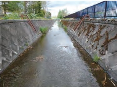
写真－3 第1幹線 S式ブロック区間（法勾配 1 : 0.5）
