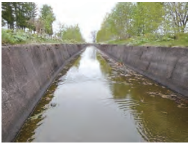
写真－1 導水路フリューム区間（法勾配 1 : 0.3）
