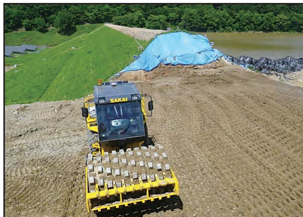
写真－2 ダム軸方向転圧
