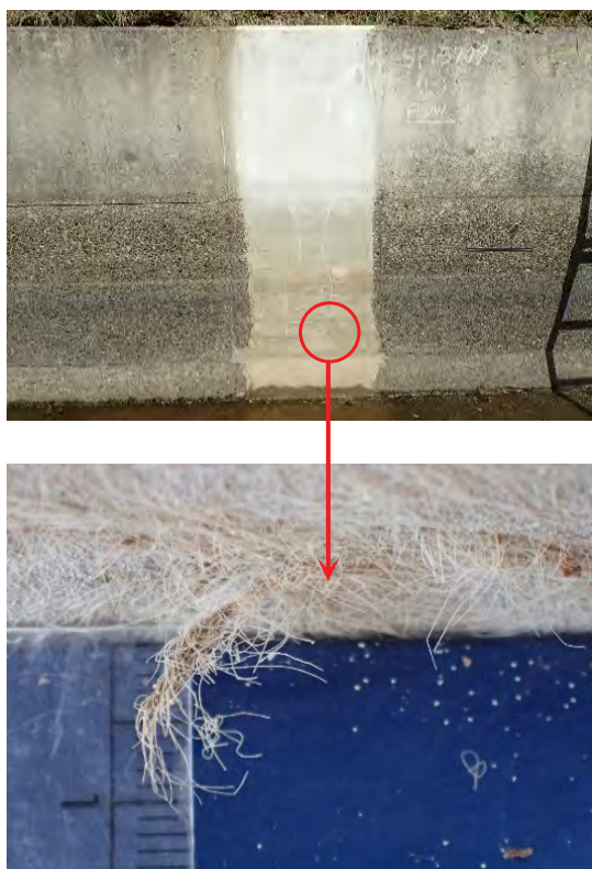
図－9 韌性セメント目地工法の状況（平成27年）
