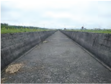
写真－2 導水路重力式擁壁区間（法勾配 1 : 0.3）
