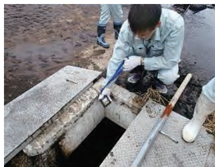
写真－５ ガス測定状況
