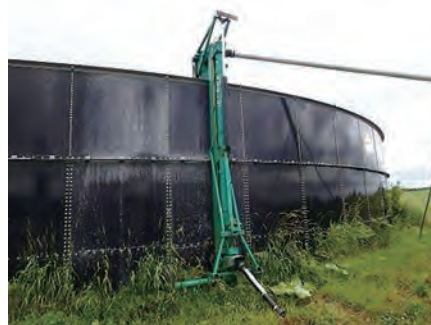
写真ー9 配水調整槽の可視部に異常なし
