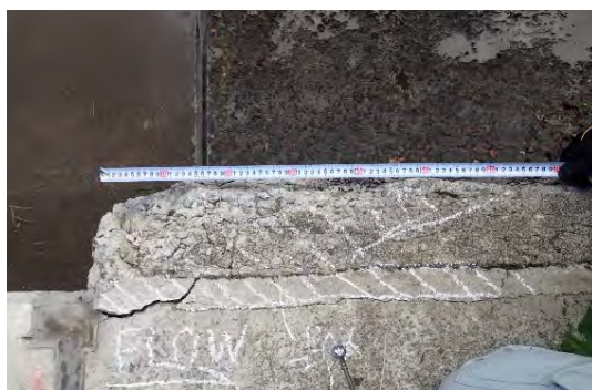
図－10 応力機能目地工法の状況（平成27年）
