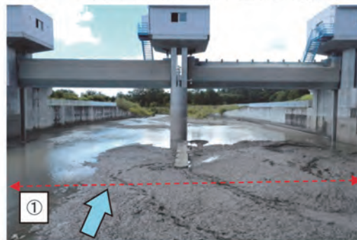
エプロン上流(落水後:河道内より撮影)
