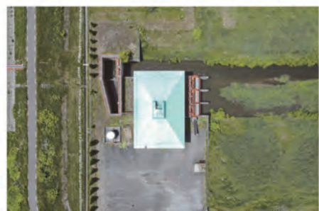
令和5年度:調整池、流入水路撮影(UAV撮影)
