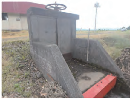
写真-6 取水施設
