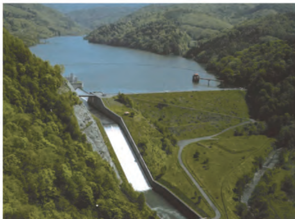
写真－1 双葉ダムの全景写真 2)
