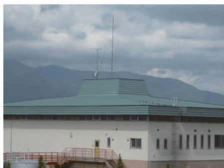
平成25年度:屋根撮影(河川堤防より撮影)
