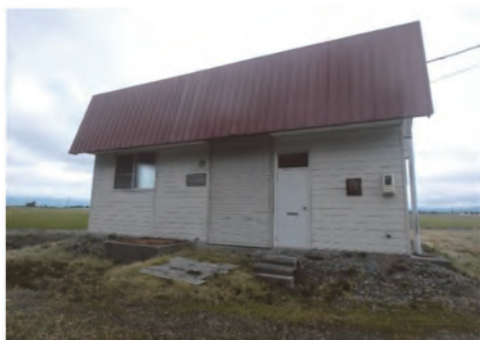
写真-1 大願第12-2揚水機
