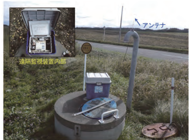
写真－7 遠隔監視装置設置状況
