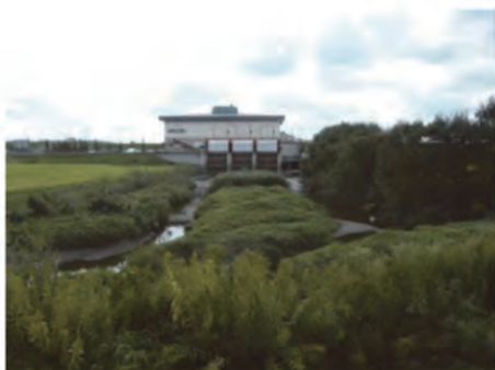
平成25年度:調整池、流入水路撮影(上流より)
