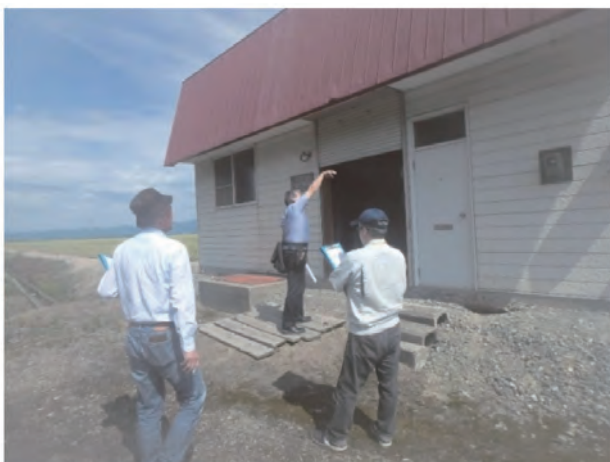
写真-4 上屋調査状況
