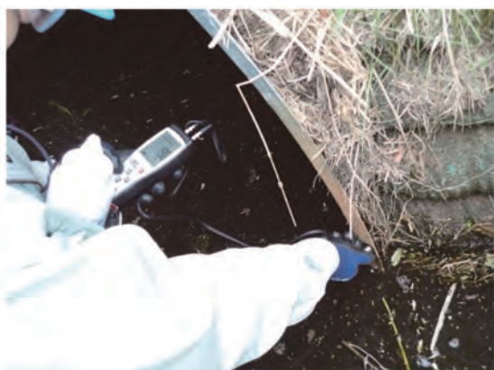
写真－5 板厚の測定
