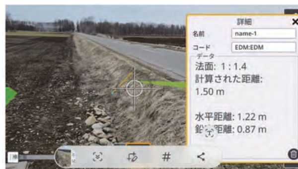
写真-7 AR機器のEDM機能による 法面傾斜勾配測定
