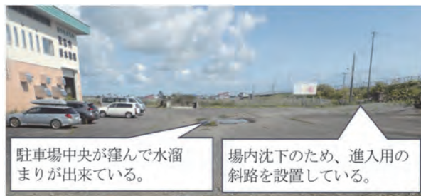
写真-7 排水機場 駐車場スペースの全景写真
