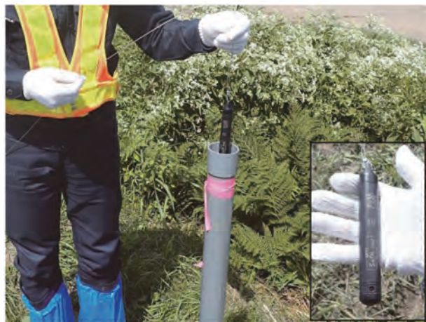
写真－11 小型絶対圧水位計の設置状況
