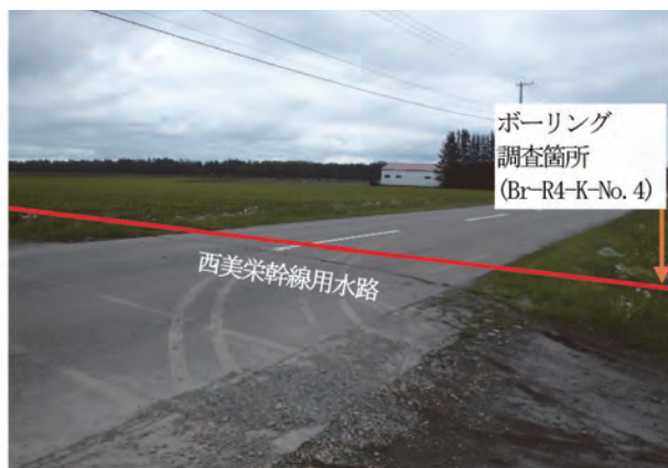
写真－10 道路横断工（推進工）（道道清水大樹線）
