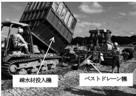
写真-3 ベストドレーン機による暗渠排水工の施工
