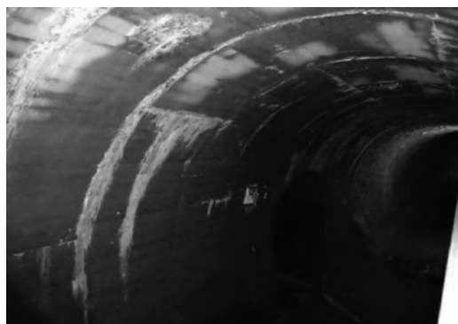
写真-3 仮排水路最奥部の状況(満水時)
