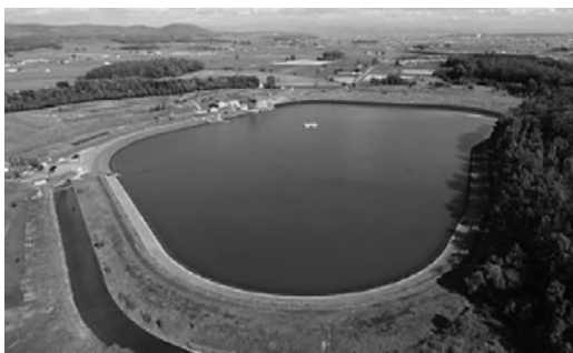
写真-4 丸山調整池
