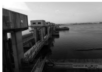
写真-1 児島湾締切堤防の全景
