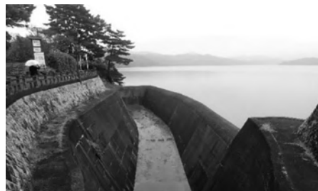
写真-6 創始とされている余水吐(昭和33年建設)
