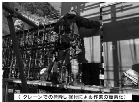
写真-3 プレキャスト埋設型枠の設置状況①
