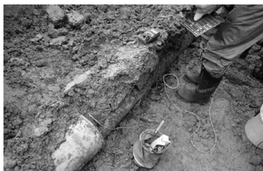
写真-7 管対地電位測定
