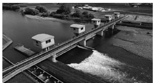
写真-3 石狩川愛別頭首工
