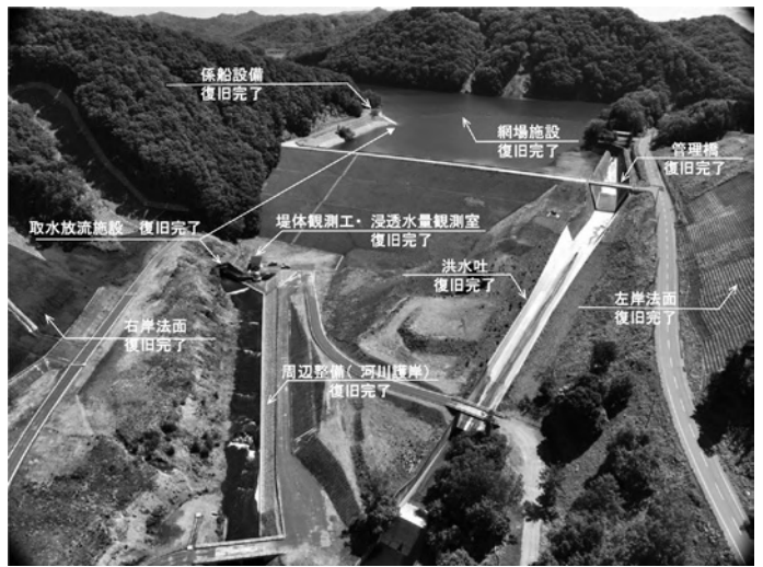
写真-7 厚真ダム復旧状況 R6.6.19
