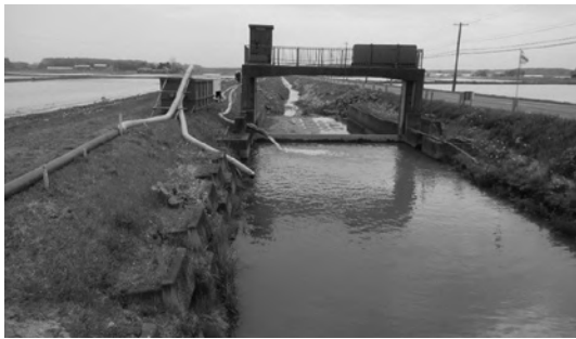
写真-5 旧施設(既設頭首工)による取水(軽舞川)R4.5.20
