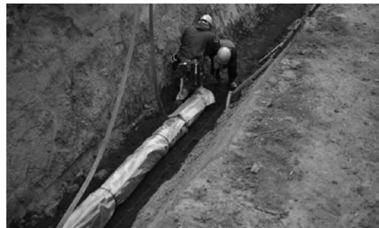
写真-3 ポリエチレンスリーブによる被覆
