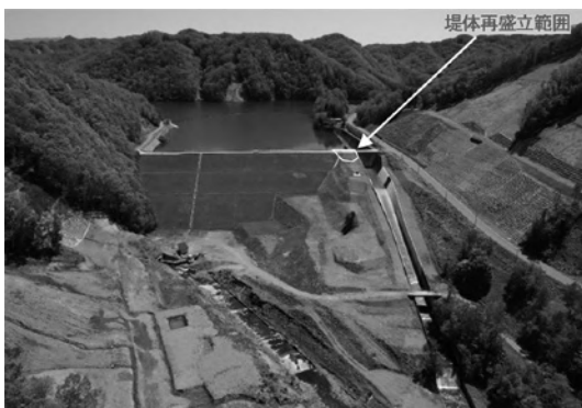
写真-2 試験湛水時の状況(満水時:R5.5.25)
