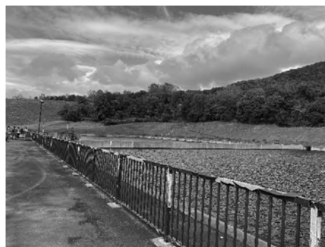
写真-7 大原調整池の全景
