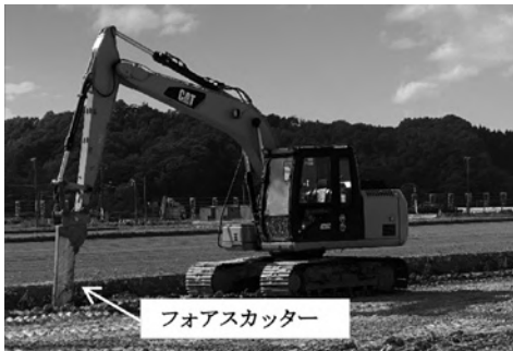
写真-2 フォアスカッターによる障害物(礫、木根等)の除去
