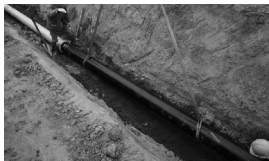
写真-5 無処置管の布設(ダクタイル鉄管)
