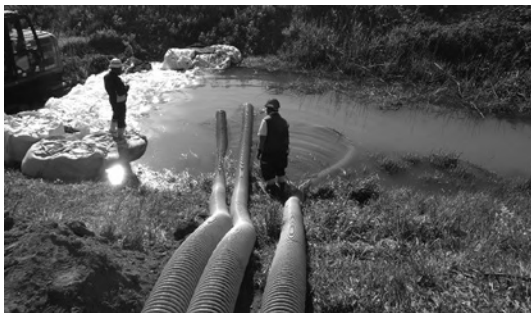
写真-6 仮設ポンプによる取水(軽舞川)R4.5.17
