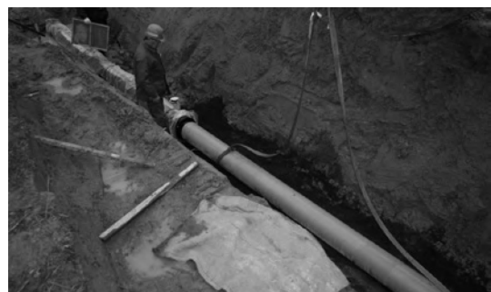
写真-4 防食塗装管の布設
