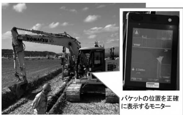
写真-4 ICT施工(畦畔築立用アタッチメントとモニター)
