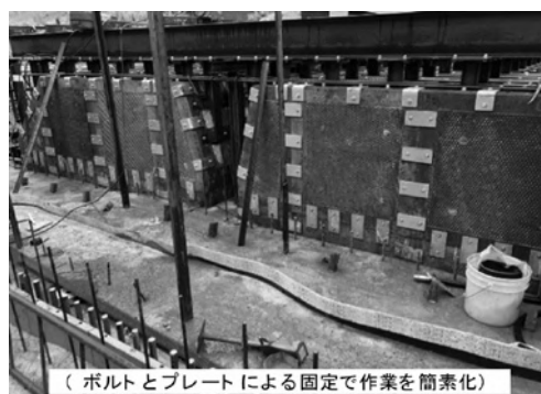
写真-4 プレキャスト埋設型枠の設置状況②
