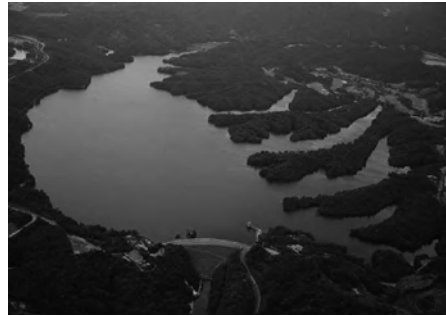
写真-4 アーチ型堤体の満濃池(研修会資料より)
