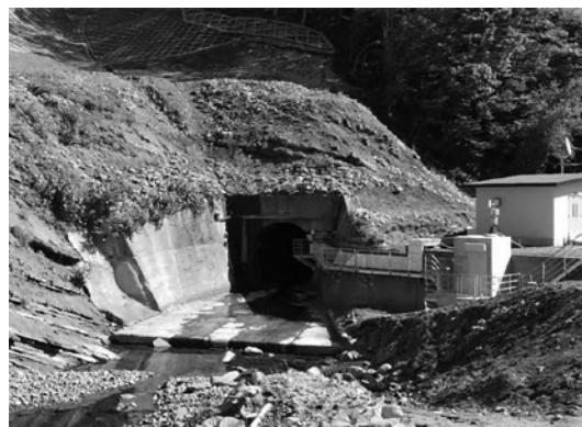
写真-4 仮排水路出口部の状況(満水時)
