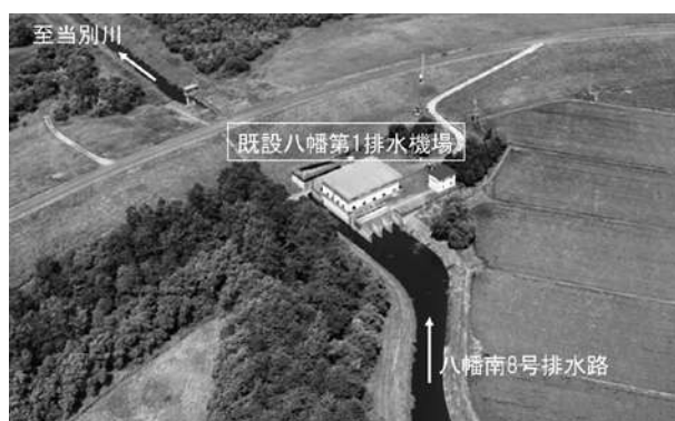
写真-1 既設排水機場全景
