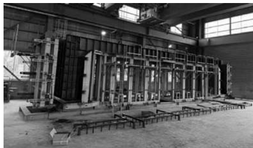
写真-3 鋼製型枠の組立状況(鉄筋・型枠組立の完了)
