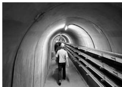
写真-6 監査廊の写真
