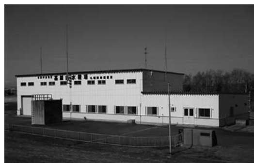
写真-2 基線揚水機場
