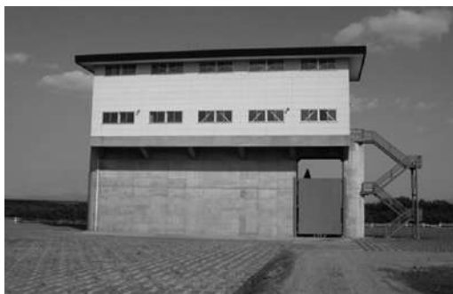
写真-3 北13号揚水機場
