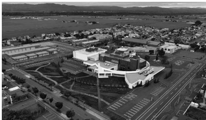
写真-2 東神楽町複合施設 はなのわ (東神楽町提供)
