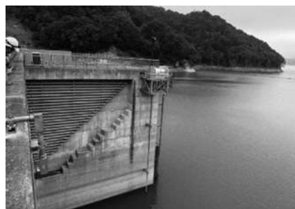
写真-5 連続サイフォン式取水設備
