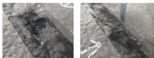
写真-8 RC常温メンテ(注入孔方式)-亀裂箇所
