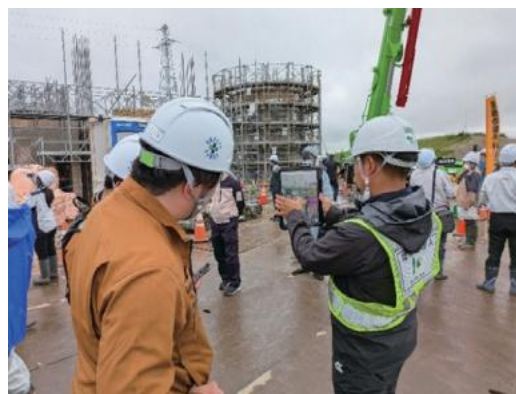
写真-6 ARを活用した現場説明の様子 (上屋・吐出し水槽)
