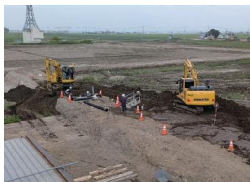
写真-1 岩見沢北村地区の施工風景
