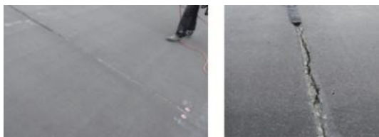
写真-5 RC加熱シーラー(Uカット)-欠損箇所
