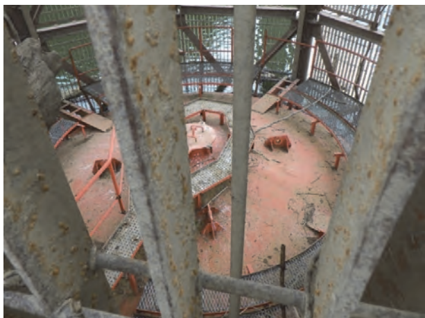
写真-20 取水ゲートのフロート部
