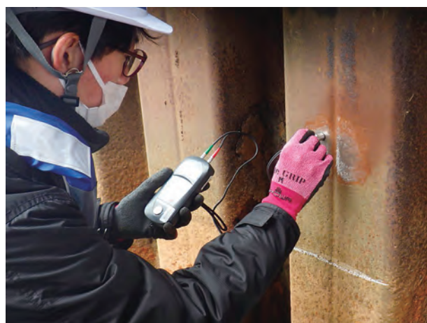
写真－8 鋼矢板の板厚計測状況
