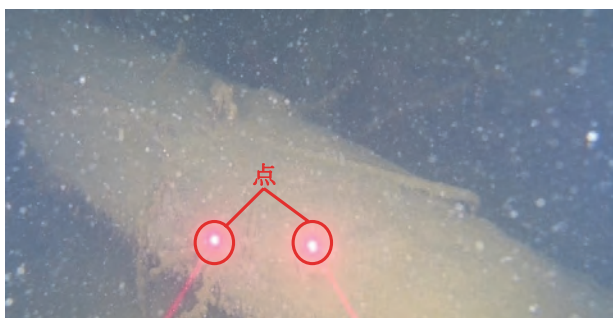
写真－12 基礎に堆積した流木
