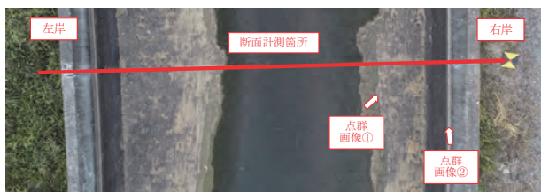
写真-2 右岸 断面計測箇所
