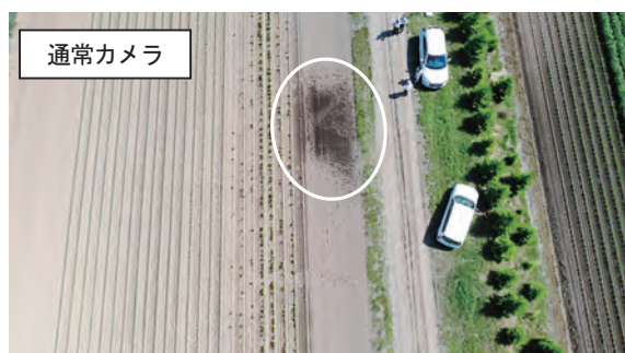
写真－19 事例) 管路地上部に湿り箇所を確認
