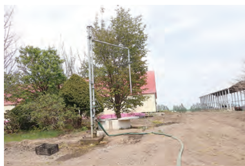
写真－４ 芽室町区域の管内洗浄（多目的給水栓）
