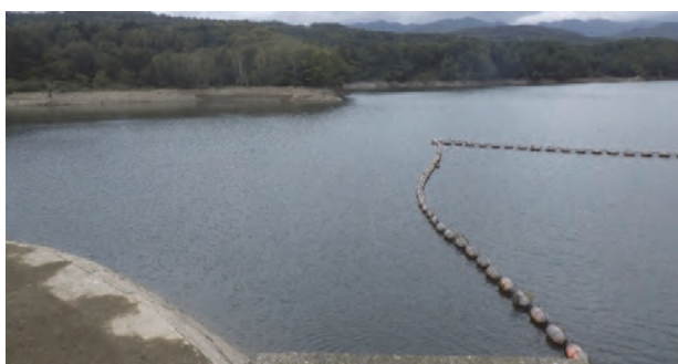
写真-18 事前調査時のダム湖水状況
