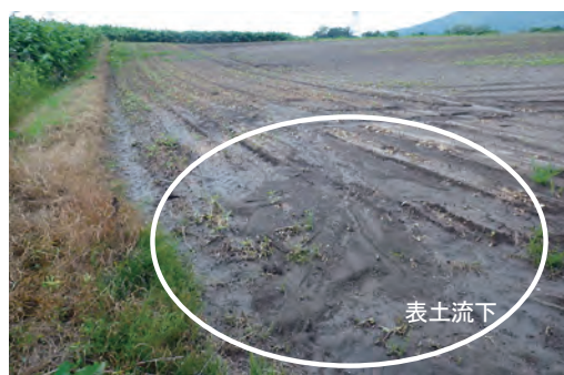
写真-3 排水不良箇所
