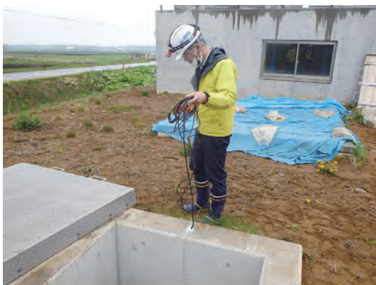
写真－16 ガスモニターの使用
