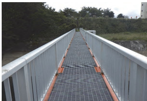
写真－３ 操作場所の管理橋
