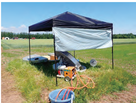
写真－15 日除けタープの設置
