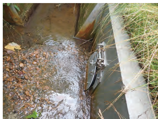
写真－23 排水施設（排水先）で濁り具合を確認
