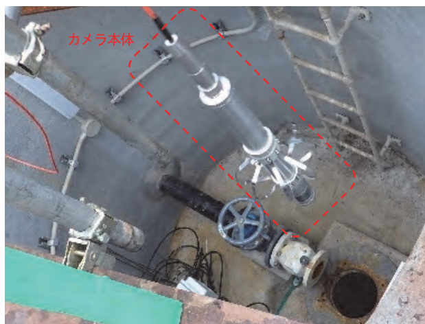
写真－3 カメラ挿入状況
