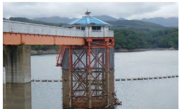
写真－1 真駒内ダム取水塔
