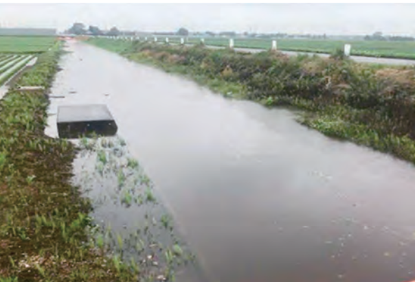
写真－1 排水路水位の上昇（平成 30 年 7 月）
