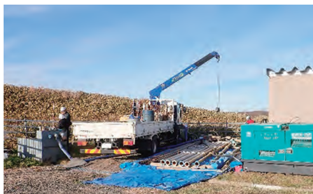
写真－6 作業全景
