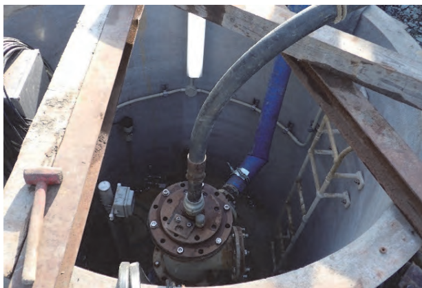
写真-7 エアー管設置状況
