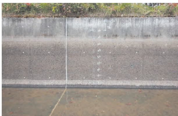
写真－2 A幹線地点1 側壁全景
