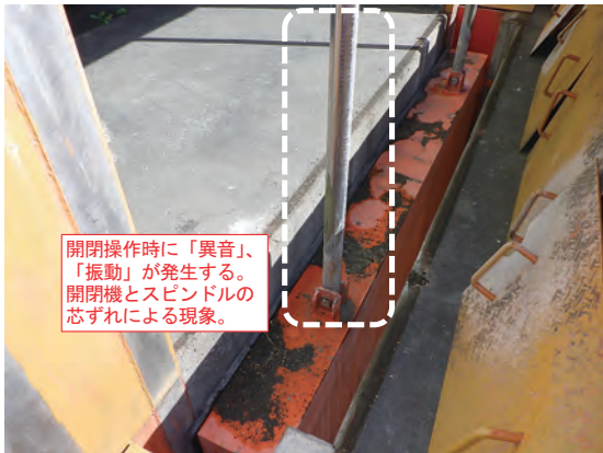
写真-6 ゲート（扉体、スピンドル）点検
