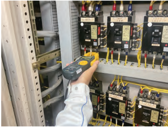
写真-5 電気・水管理制御設備 絶縁抵抗測定
