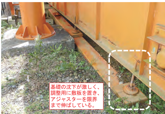
写真-7 除塵機（水平ベルコン）点検
