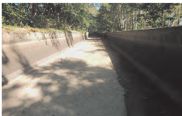
写真－1 用水路内側の全景
