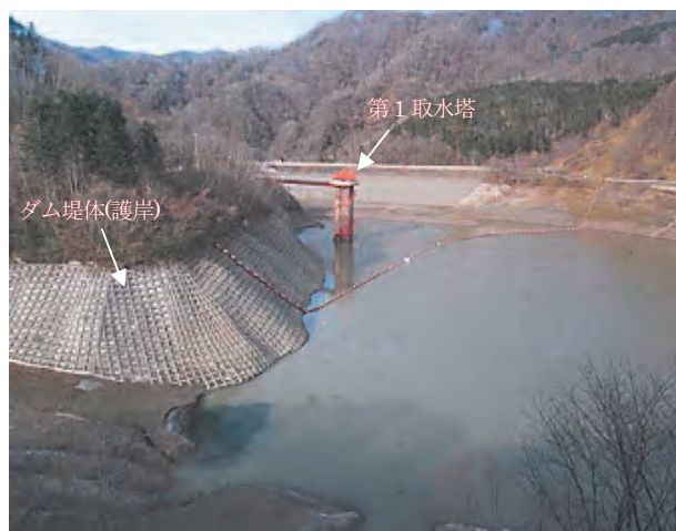
写真－2 三石ダム上流側より撮影
