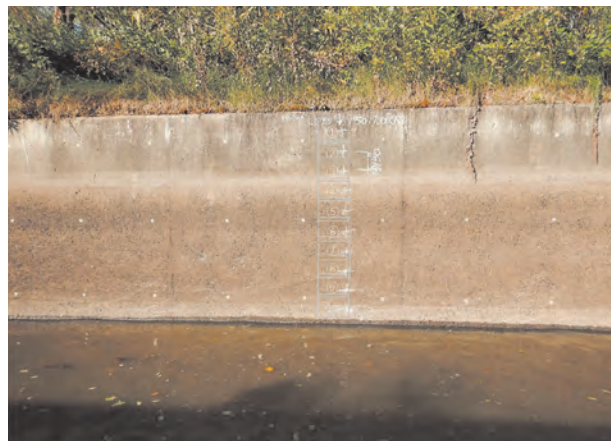
写真－4 A幹線地点2 側壁全景
