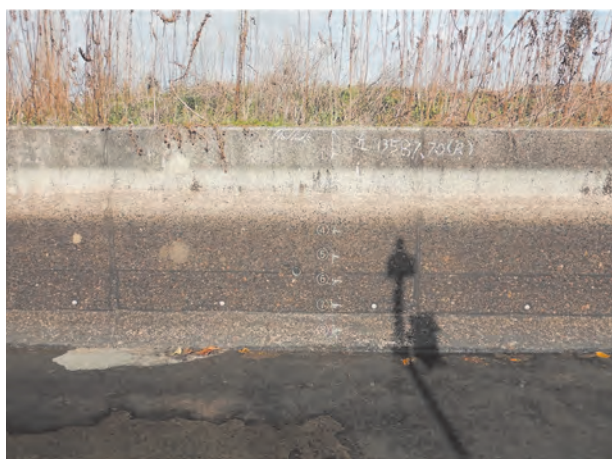
写真－5 B幹線地点3 側壁全景
