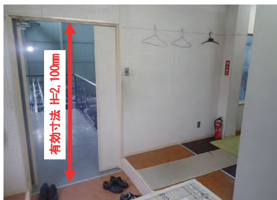
写真-13 操作室の扉
