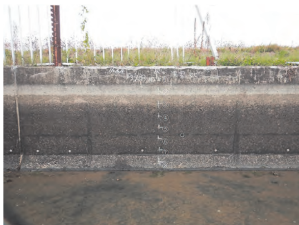
写真－6 B幹線地点4 側壁全景
