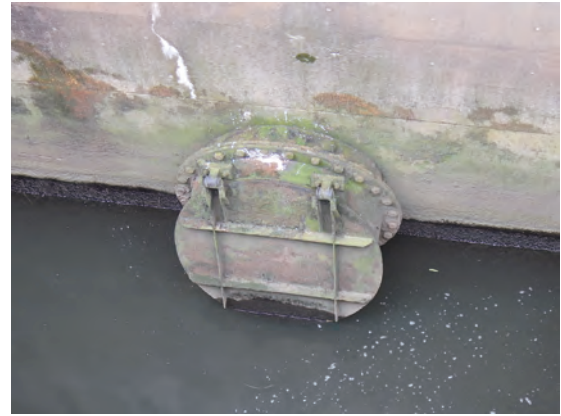
写真-9 吐出し水槽フラップ弁 状況
