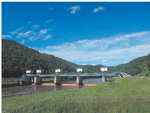
写真－１ 神竜頭首工
