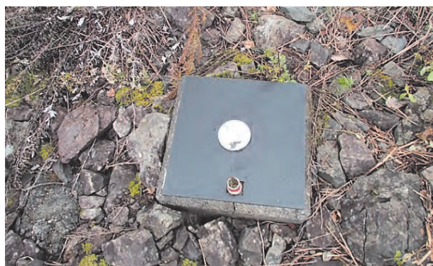
写真－７ 堤体表面変位計
