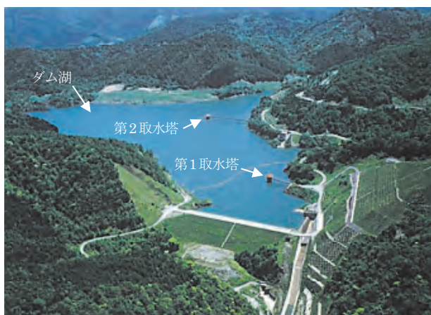
写真－1 三石ダム全景（過年度資料抜粋）
