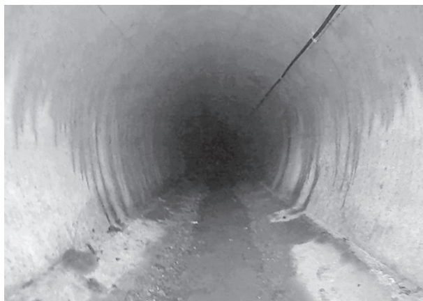
写真－２ トンネル内部状況
