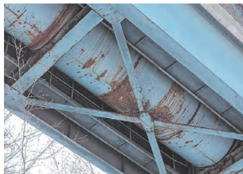
写真－３ 水管橋下面の撮影
