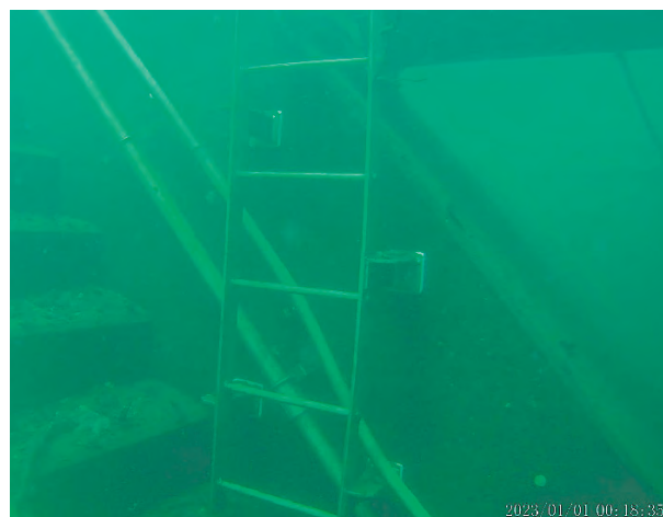
写真－5 点検架台梯子
