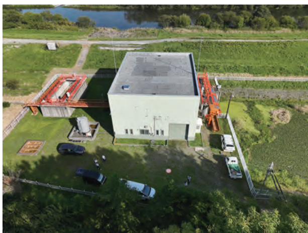
写真－2 機場全景（西面）
