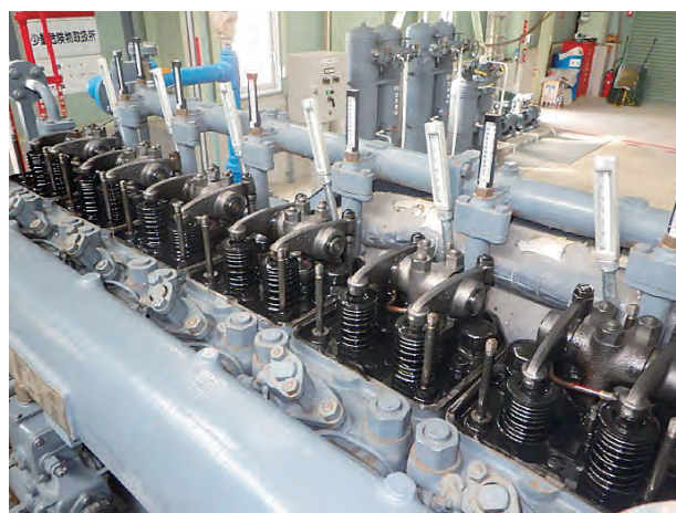
写真－４ 主原動機動弁装置 点検
