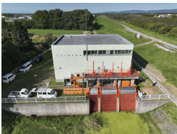
写真－1 機場全景（南面）
