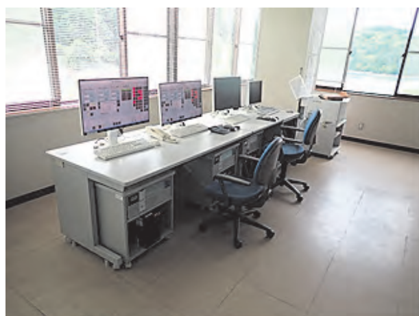
写真－5 管理棟（管理室内）
