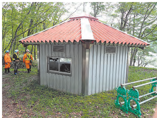
写真－3 第2ゲート室（外観）
