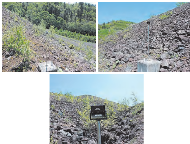
写真－４ 堤体表面変位計（上左：C3、上右：B4、下：C4）
