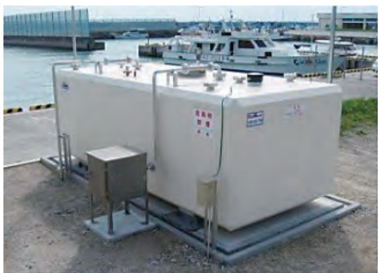
写真－11 コンボルトタンク（施工事例）
